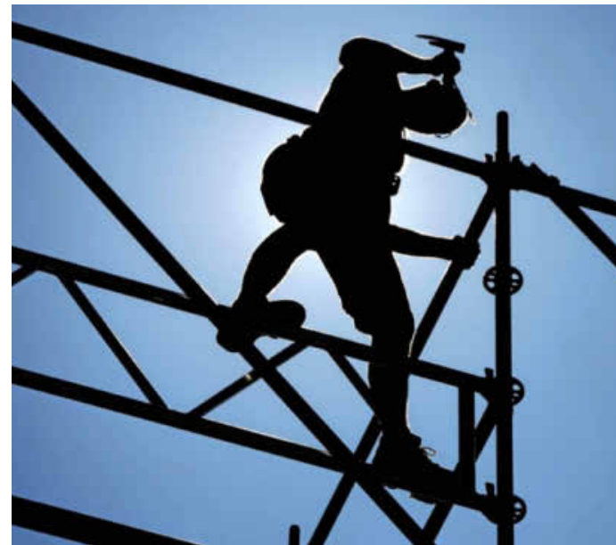
Auf der Baustelle lauern viele Risiken: Wer Freunde als Helfer einsetzt, sollte diese versichern.
