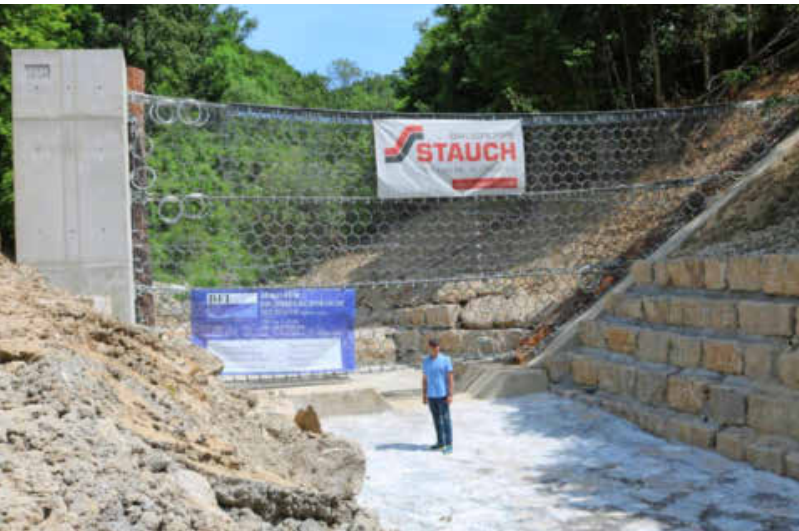
Der größte dynamische Geröllfang Deutschlands steht am Orlacher Bach, dessen zerstörerische Fracht dem Ort am 29. Mai 2016 zum Verhängnis wurde. Foto: Ralf Reichert
