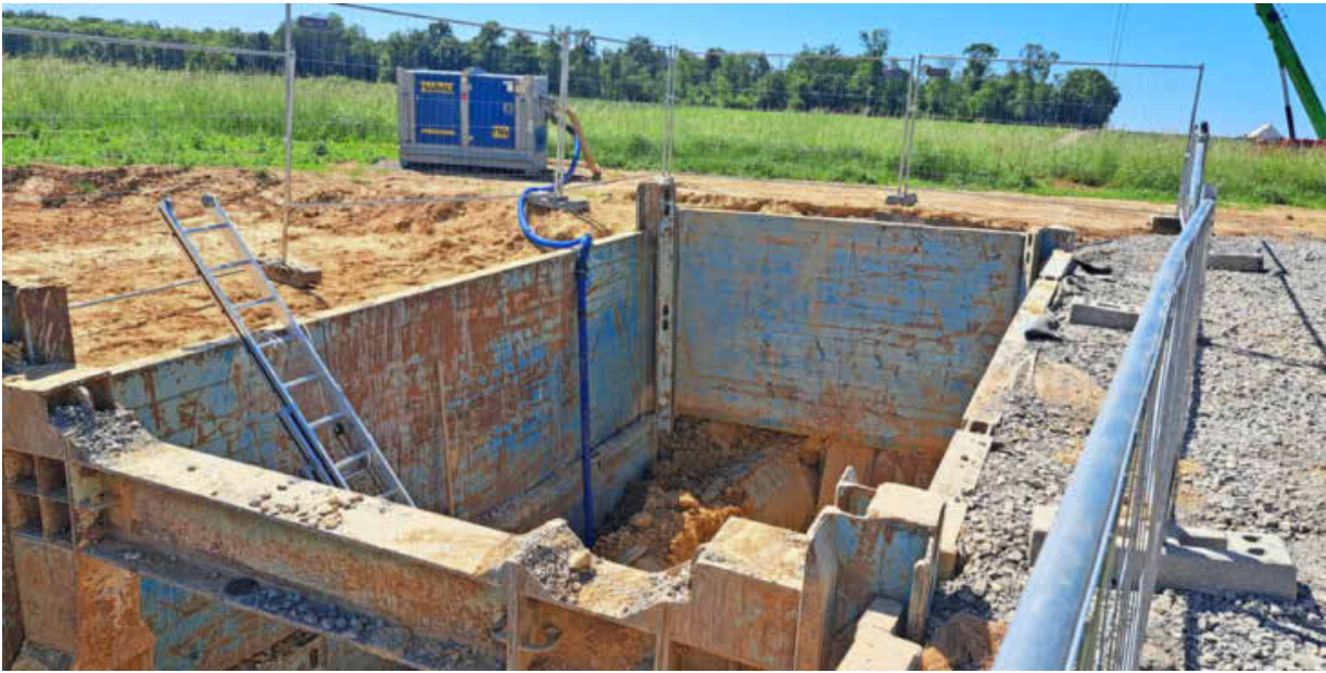
Um die Rohre unterhalb einer Straße zu verlegen, wird eine Pressbohrung durchgeführt. So muss die Straße für Autofahrer nicht gesperrt werden.
