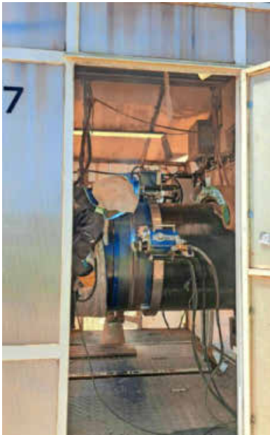
Bei fast 30 Grad sind die Schweißer in voller Montur dabei, die Rohre zu löten.
