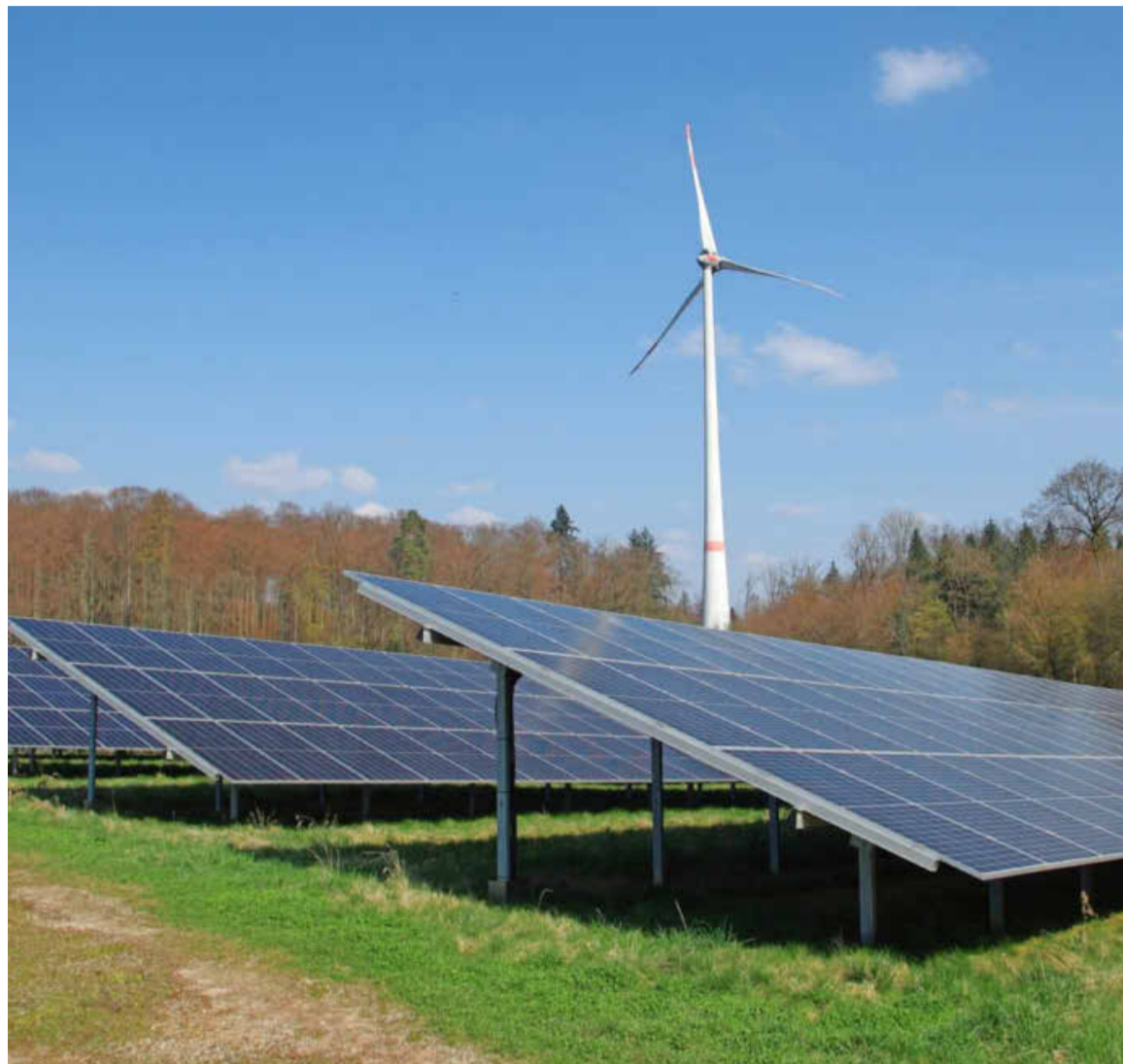
Der Wind- und Solarpark im Harthäuser Wald ist die größte Anlage, die von der Zeag in der Region betrieben wird. Im vergangenen Jahr kamen vier Windräder und zwei Solarparks hinzu.
