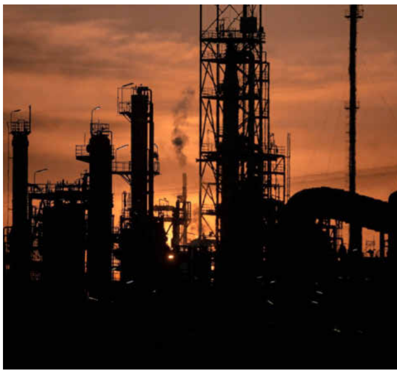
In Anlagen wie der Mineralölraffinerie Oberrhein (Miro) bei Karlsruhe wird Rohöl zu Kraftstoffen und petrochemischen Vorprodukten verarbeitet.
