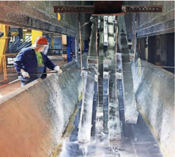
Bei der Coatinc Company in Kreuztal werden unter anderem verzinkte Stahlträger hergestellt.
