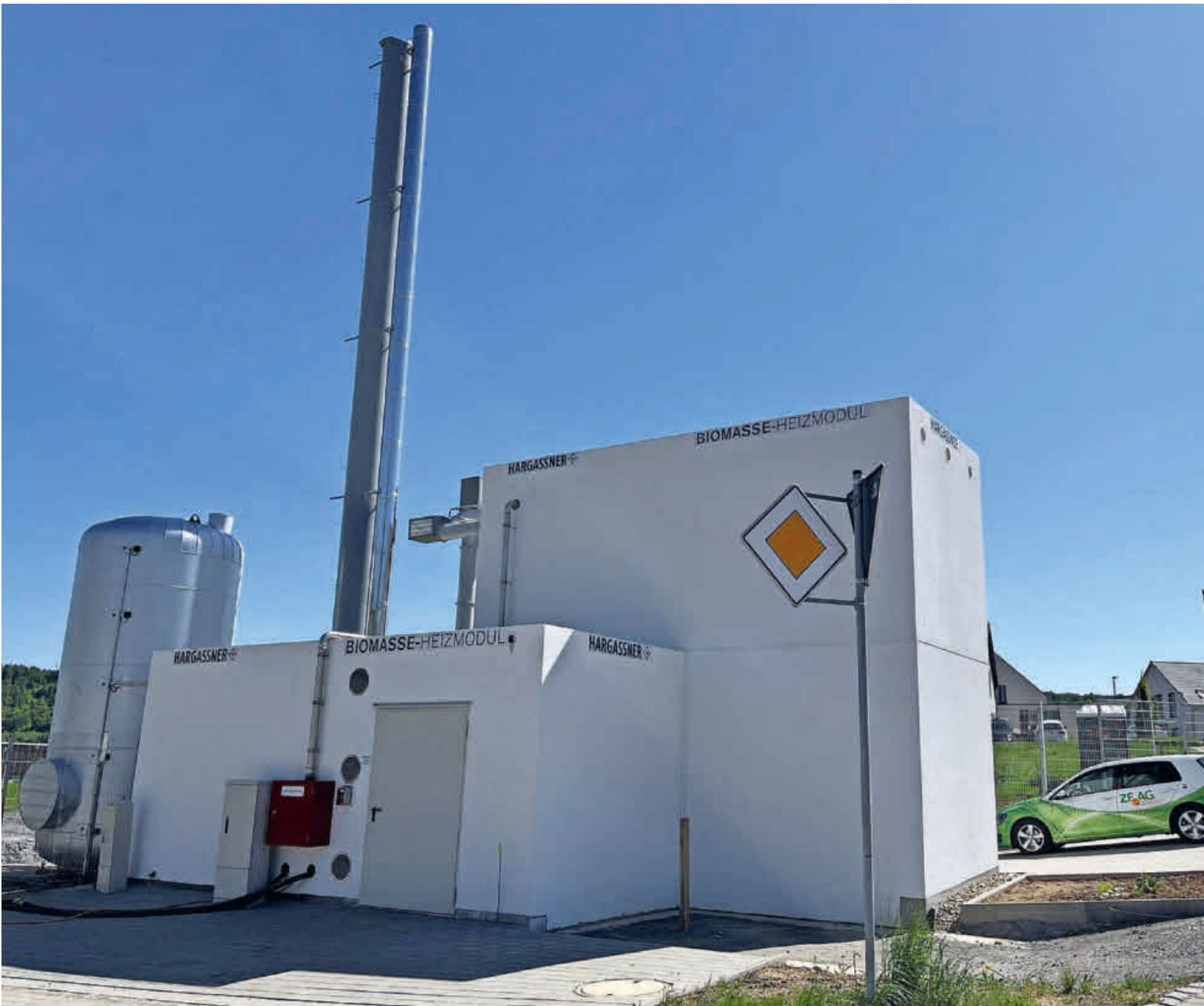
Im Neubaugebiet Kirchhofäcker-Krautgärten versorgt seit kurzem eine Heizzentrale elf Einfamilienhäuser. Eigene Heizungen werden damit überflüssig.
