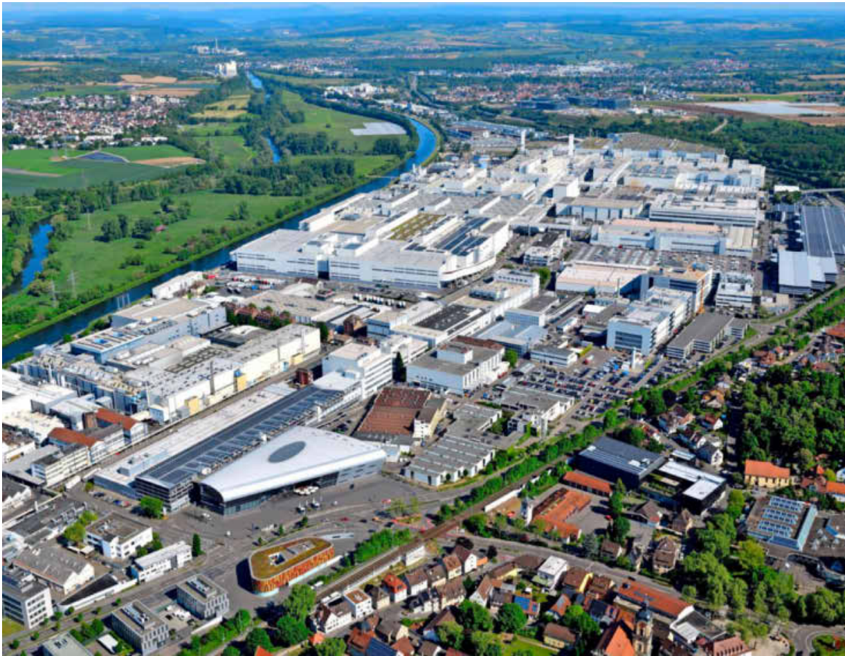
Am Audi-Standort Neckarsulm arbeiten rund 15.000 Menschen. Aktuell ist das Werk dank der Baureihen A5 und A6 wieder besser ausgelastet. Noch ist allerdings offen, welche Modelle dort in den 2030er Jahren gefertigt werden.
