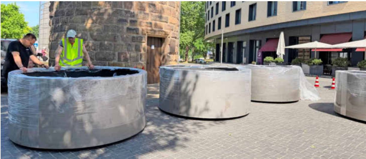
Die ersten Sicherheits-Pflanzenkübel in der Innenstadt wurden am Mittwochmorgen nahe des Bollwerksturms in der nördlichen Innenstadt aufgestellt.
