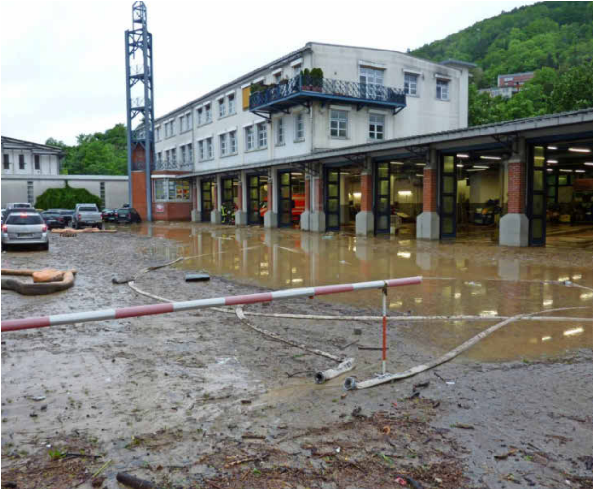
In der Nacht stand das Wasser in der Feuerwache und dem Hof davor, hinterließ eine teils 70 Zentimeter hohe Schlammschicht. 300.000 Euro Schaden entstand allein an den Privatautos der Feuerwehrleute, die im Hof geparkt hatten. Foto: Archiv/Zimmermann
