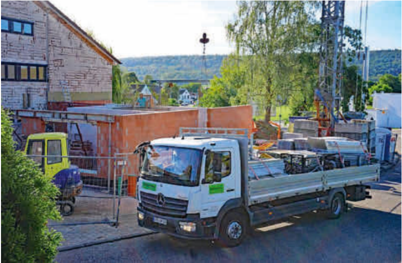
Die Arbeiten laufen. Der Erdgeschoss-Rohbau für die Ganztagsbetreuung der Grundschulkinder steht bald.
