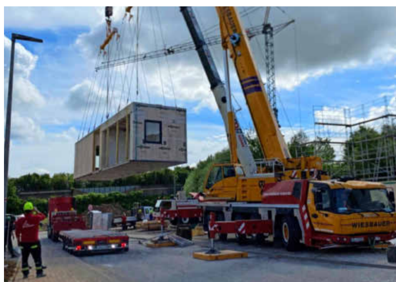
Achtung, hier kommt die neue Kita. Zwei Autokräne heben die Module von den Tiefladern und setzen sie an Ort und Stelle.
