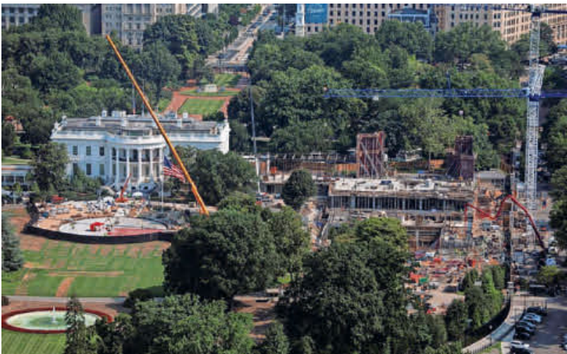
Der Ballsaal wird seit dem Herbst 2025 auf dem Gelände des ehemaligen Ostflügels des Weißen Hauses errichtet. Foto: dpa
