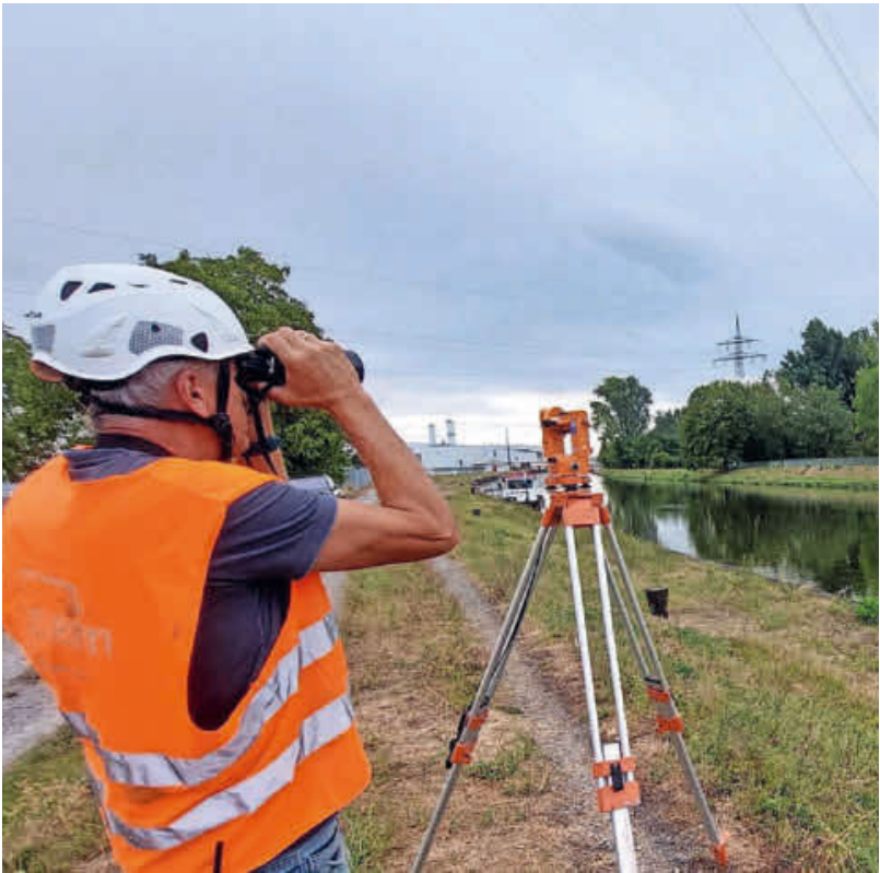
Nur mit Fernglas zu erkennen: Auf dem Damm des Schleusenkanals hat der Mitarbeiter der beauftragten Firma seine Kollegen im Abspannmast genau im Blick. Foto: Plückthun
