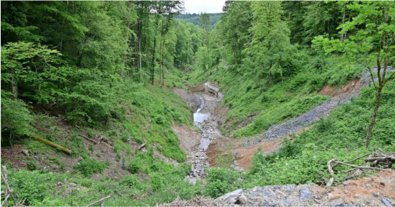
Die Sanierung der Klinge in Ernsbach war eine der teuersten Maßnahmen der Stadt Forchtenberg.
