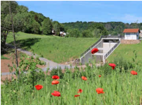
Das Rückhaltebecken im Niedernhaller Bachwiesental soll den Forellenbach im Falle eines Starkregens zähmen.
