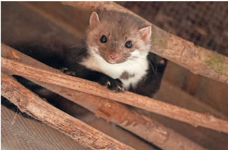
Ein Marder sorgte in der Nacht zum Montag für einen kurzen Stromausfall in Kirchardt und mehreren Orten im Kraichgau. Ursache war ein Kurzschluss in einer Trafostation bei Obergimpfern. (Symbolbild) Foto: Philipp Schulze/dpa
