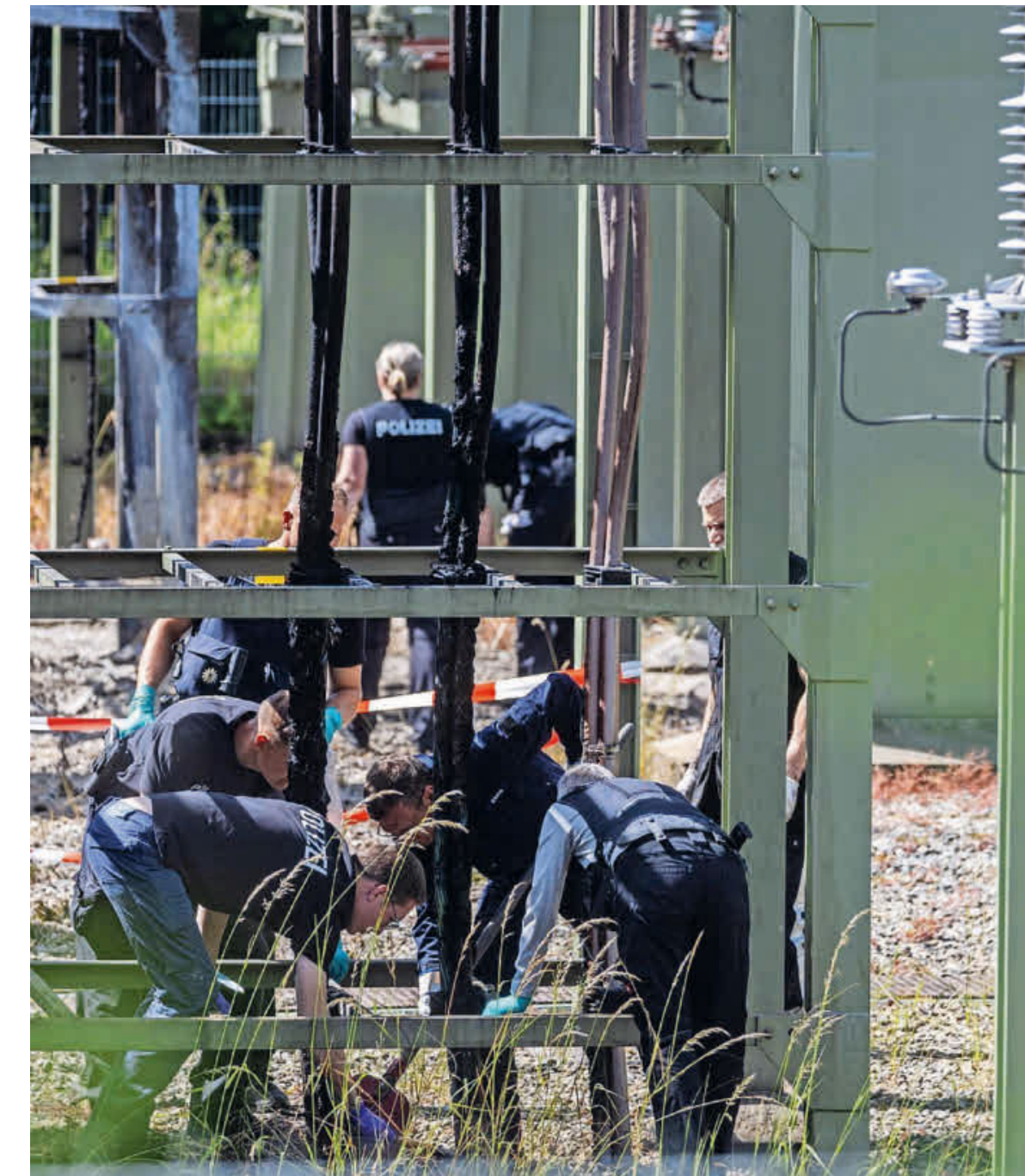
Linksextremisten rufen in einem Schreiben zu Sabotageaktionen auf. Erst im Juni kam es in Reutlingen zu einer gezielten Brandstiftung an einem Umspannwerk.
