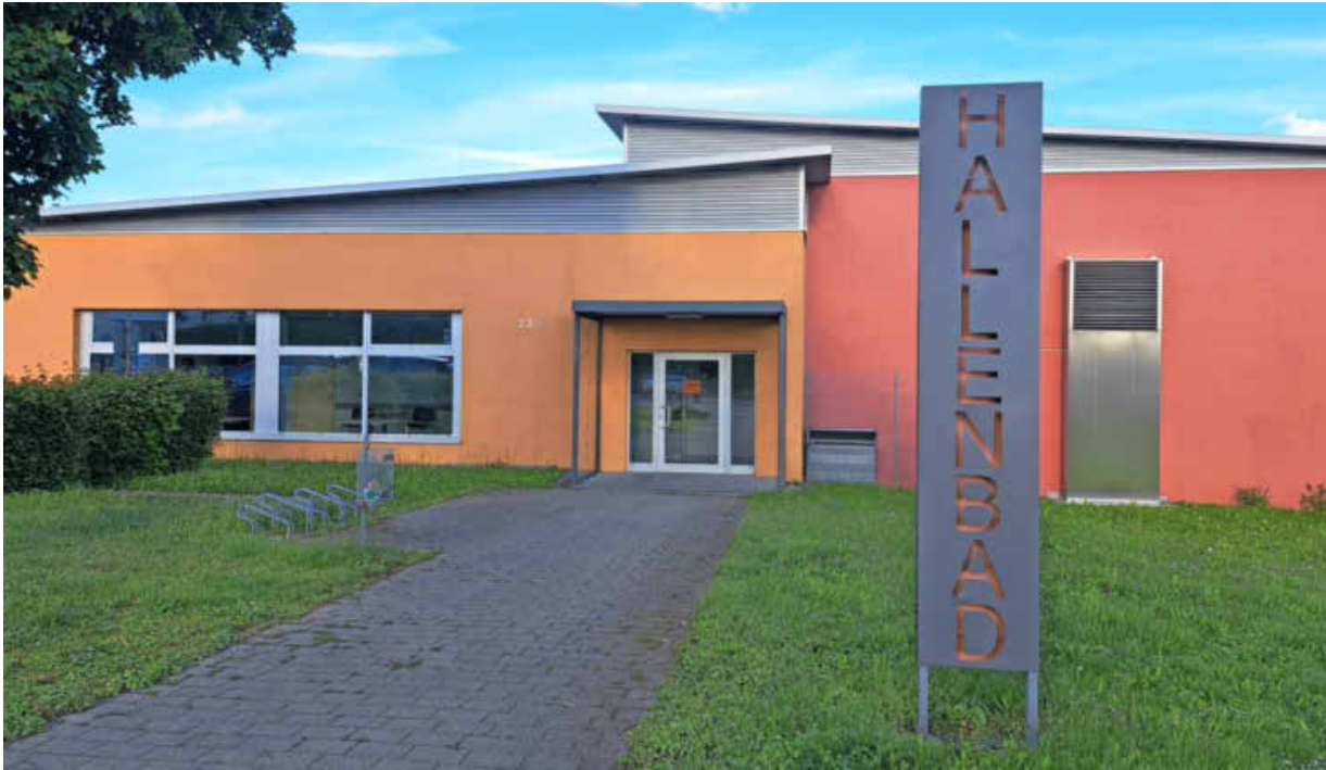
Das Hallenbad in Kirchardt wird für 3,7 Millionen Euro saniert. Die markanten Farben werden nach der Fertigstellung nicht mehr die Außenfassade zieren.
