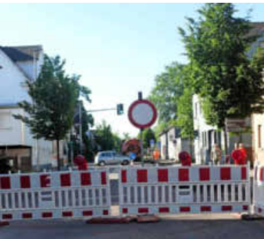
Die Stuttgarter Straße ist seit Dienstagvormittag gesperrt.
