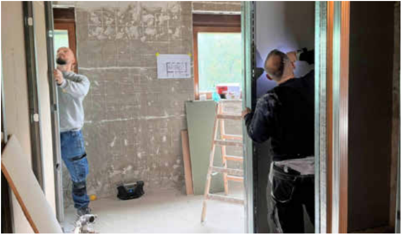
Flamol Alimusaj und Qlirim Gashi von der Ilsfelder Trockenbaufirma H. Lutz haben mit dem Ausbau der Sanitärräume begonnen.
